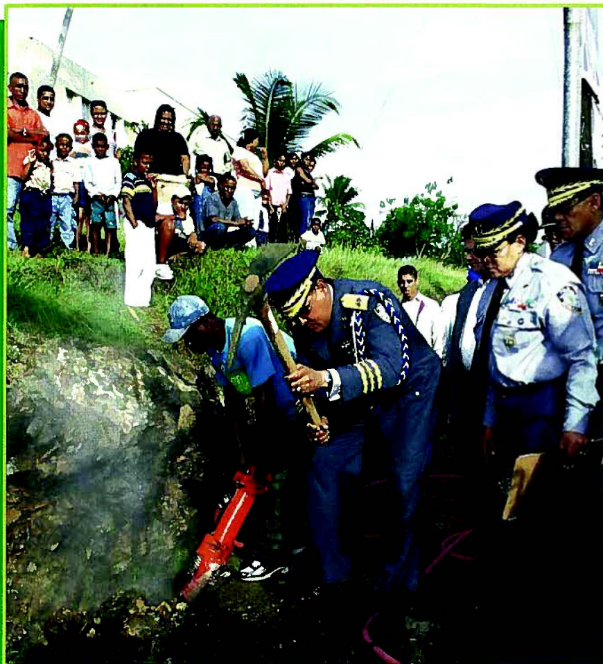
El jefe de la Policía Nacional teniente general Bertando Santana Páez da el primer picazo para dejar iniciada la construcción de un nuevo destacamento en El Seibo.
